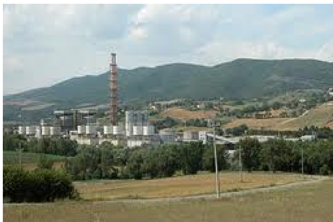
Centrale termoelettrica di Ponte di Ferro – Gualdo Cattaneo
